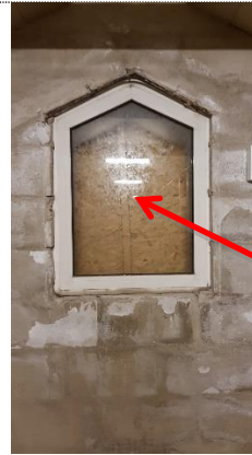
Bilde 13: Tidligere vinduer i «seksjoneringsvegger» på loft tettes igjen med brannplate slik at brannmotstand A60 ivaretas.
