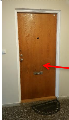
Bilde 1: Svært mange dører til boenheter er uklassifiserte tredører med brevsprekk.
