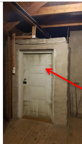
Bilde 8: De fleste loftsdoorer er uklassifiserte tredører eller metallbeslåtte tredører.
