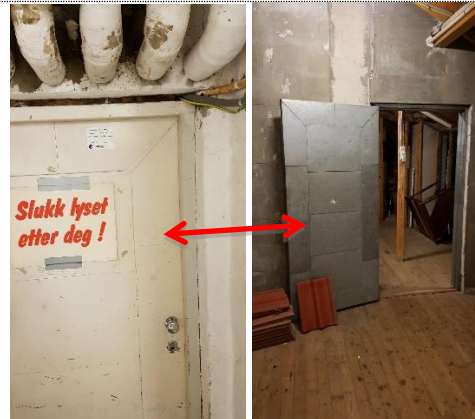
Bilde 5-6: Dører i kjelleretasje er uklassifiserte metallbeslåtte tredører.
